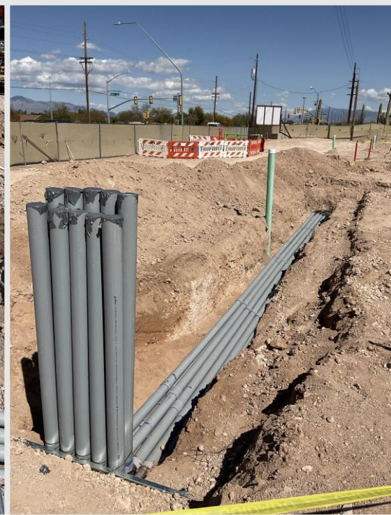
Conduit for the transformer
