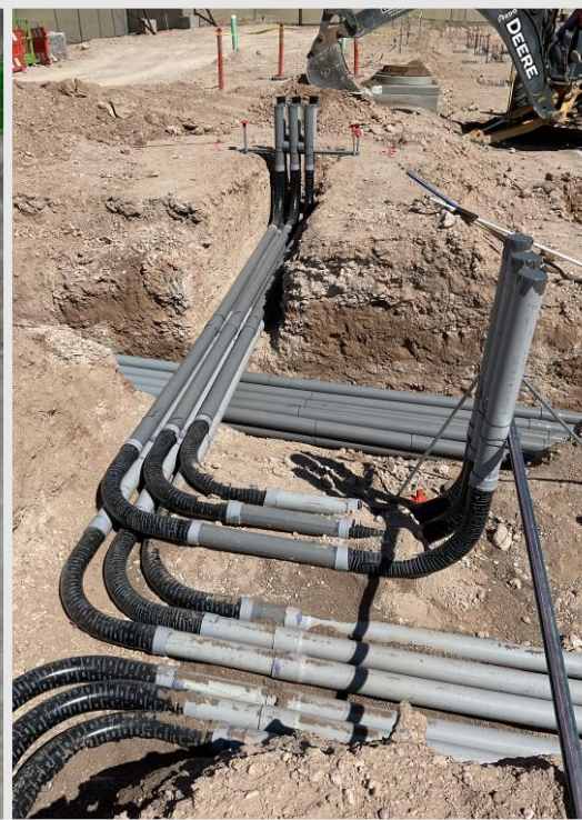
Conduit for generators
